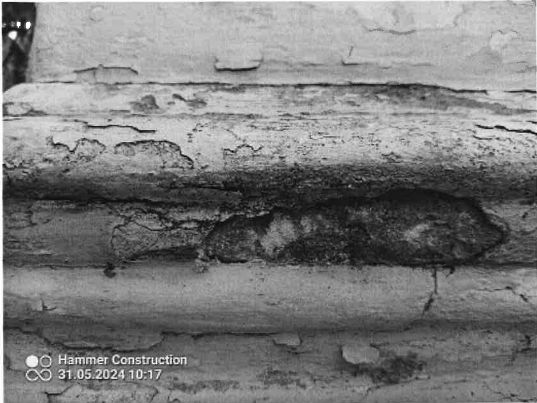
Murszejący kamień widoczny pod wtórnymi warstwami
