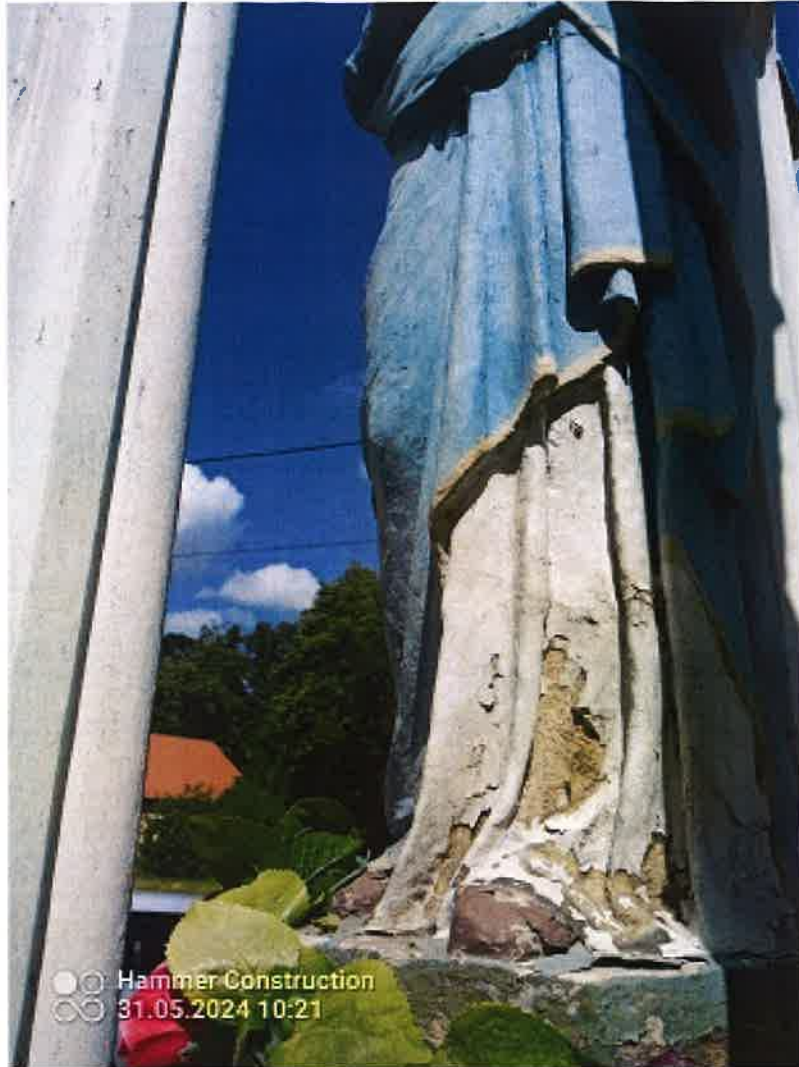
Uszkodzenia kamienia w dolnej partii płaszcz Matki Boskiej
