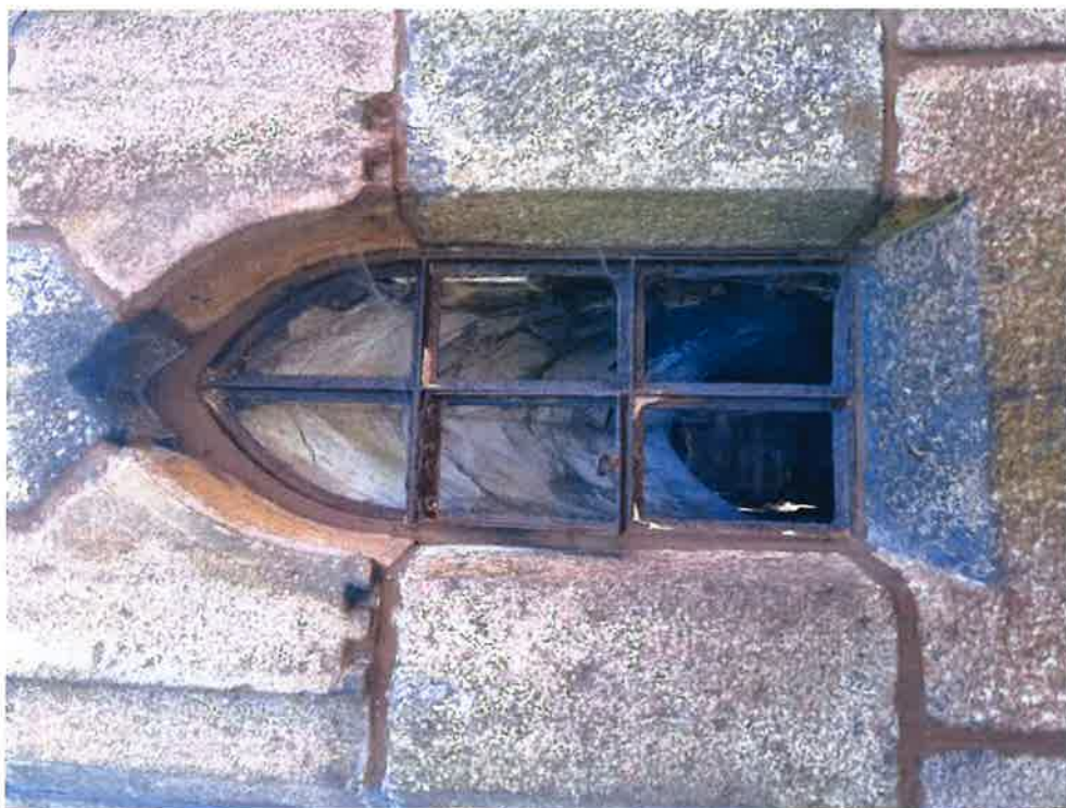
FOT. 12 jedno z czterech metalowych okienek.
