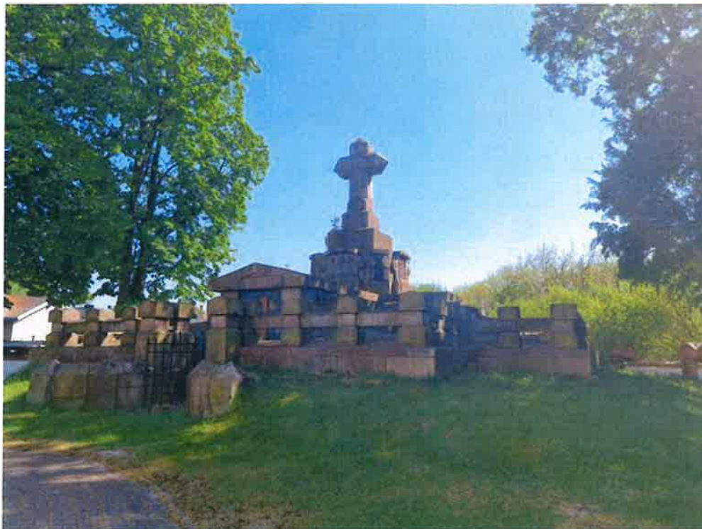
FOT. 1 Grobowiec, widok ogólny, strona frontowa.
