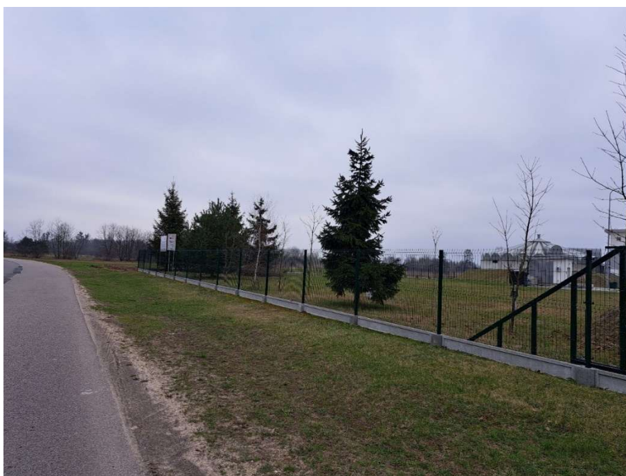
Ryc. 5. Teren oczyszczalni ścieków
