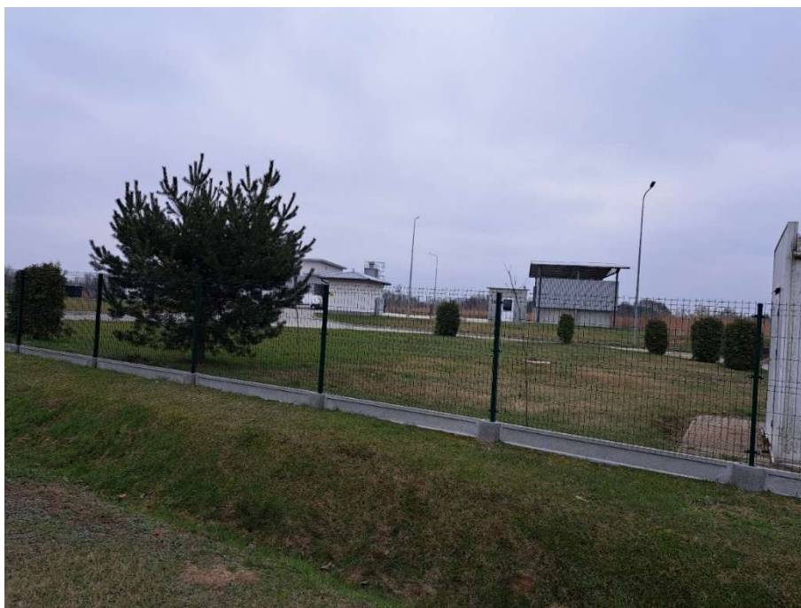
Ryc. 4. Teren oczyszczalni ścieków
